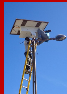
Installation d'un lampadaire solaire
